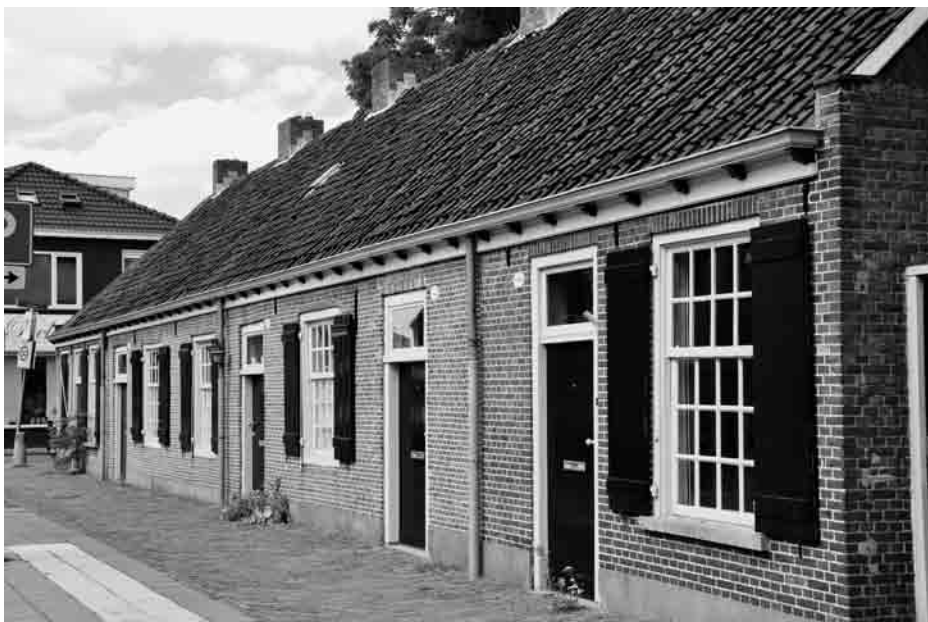
karakteristieke arbeidershuisjes (Tilburg)
